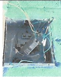
Foto 6: reparación de sistema eléctrico en mal estado
